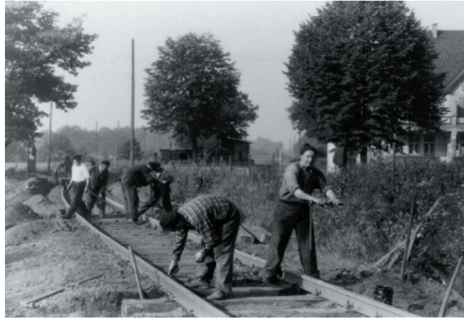
Gleisbauarbeiten am Glinde Bahnhof
